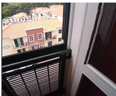
Janela com grelha em baixo
