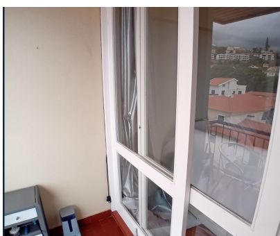
Caixilharia de madeira pintada
