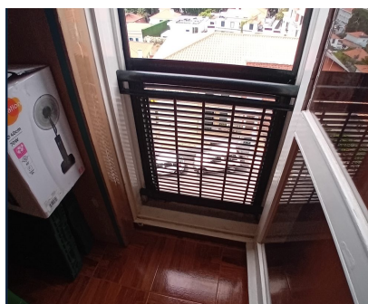
Porta de sacada com grelha
